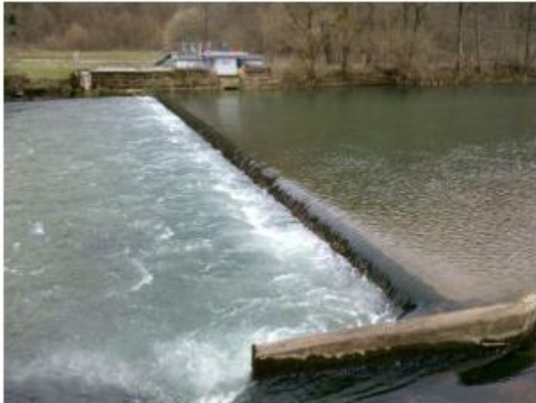
A gauche, le seuil de Chenecey avec la passe à canoë ; à droite, la prise d'eau de la station de pompage
